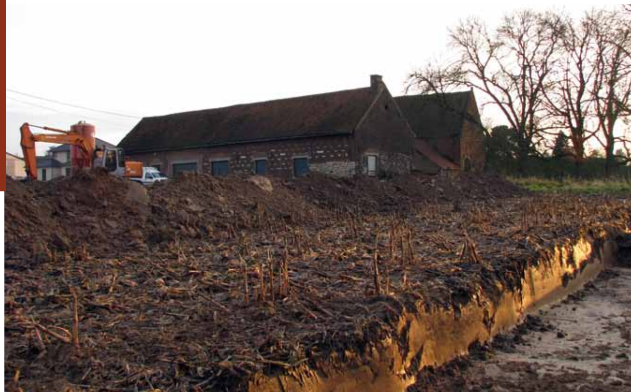
Zicht op het "Pachthof der zevenslapers" met op de voorgrond een deel van het plangebied. (© Archaeological Solutions)
